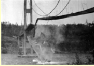
El Tacoma en el instante del colapso.
