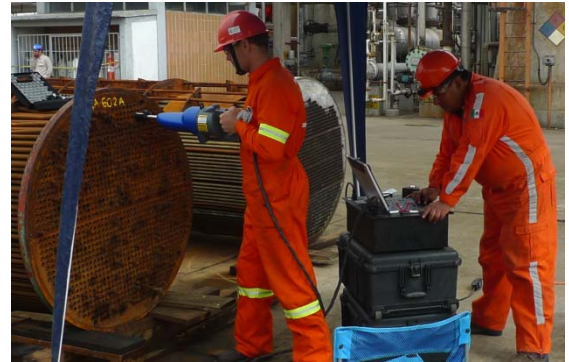
Fig. 4: Inspección de tubos de intercambiador de calor por medio de sistema RPA; a derecha inspector y unidad de control computarizada, y a izquierda – operario tomando mediciones con sonda acústica.
